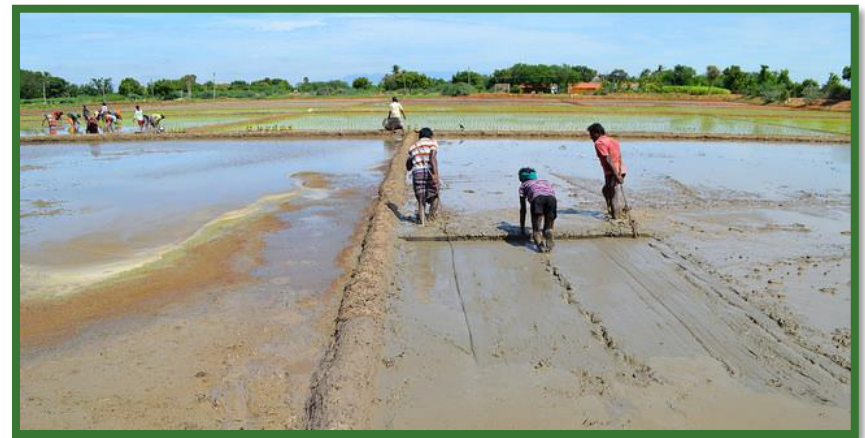
Création de digues agricoles et de petits barrages pour permettre une irrigation optimale et économe en eau
